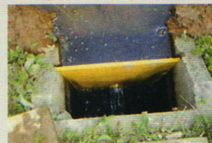
排水口を絞る排水調整板
